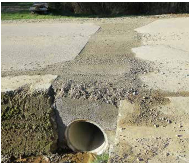
Na novo urejen propust čez cesto - Dolnji Slaveči - Mekišov bregj
