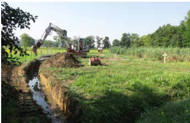
Začetek sanacije. (Foto: M. Žokš)
