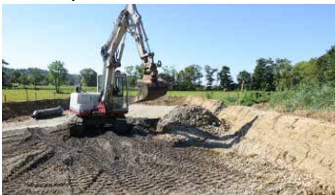
Izkop obstoječe grede.
