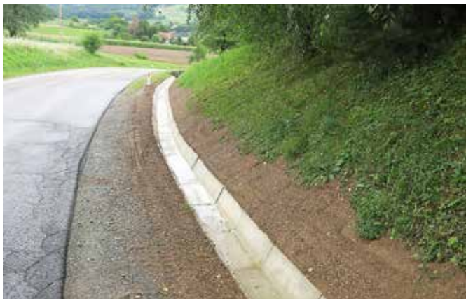
Ureditev brežine s kanaletami
